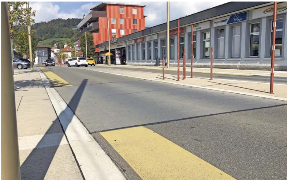
Die Bahnhofstrasse in Widnau: Der multifunktionale Mittelstreifen wird durch rote Stelen unterbrochen. Die gelbe Markierung am Strassenrand dient zur optischen Verengung. Fussgänger können die Strasse queren, wo sie möchten. Vortritt haben die Autos. Bild: Monika von der Linden
